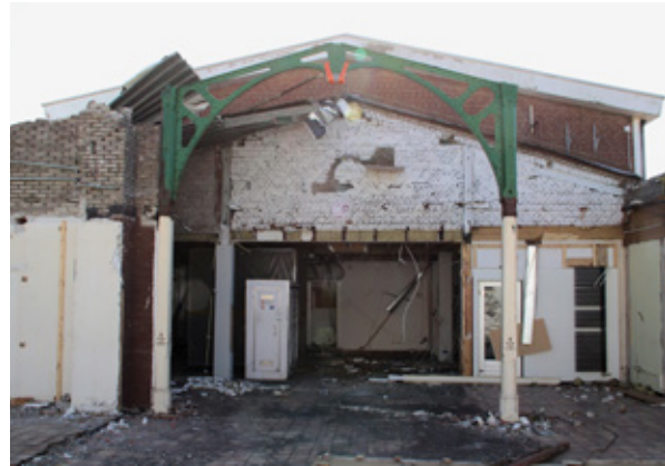
Na 76 jaar wederom sloop, nu aan de Abtswoudseweg in Delft.
